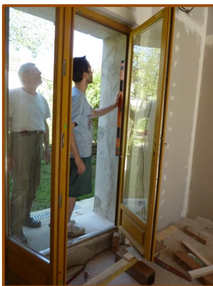
Pose de la porte fenêtre côté nord (fin août 2013)
