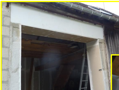
Fermeture encadrement future baie coulissante (fin août 2013)
