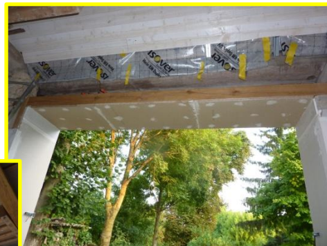
Fermeture encadrement future baie coulissante (fin août 2013)
